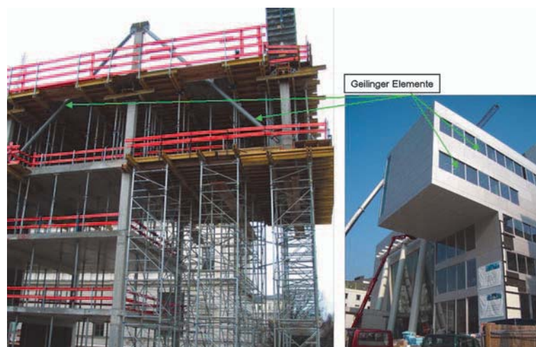
4 Brückenfachwerk für auskragende Bauteile
