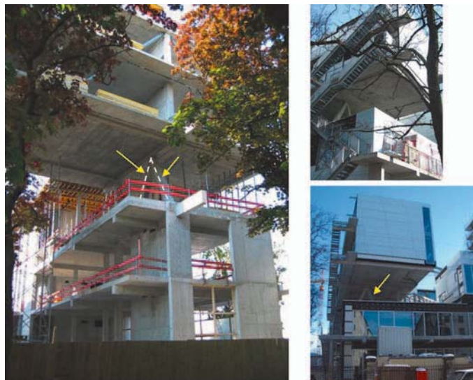
3 Stützenminimierung für »schwebende« Baukörper
