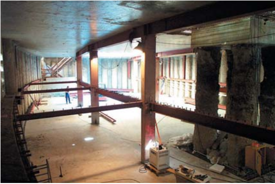
9 Montage der Zwischendecke
