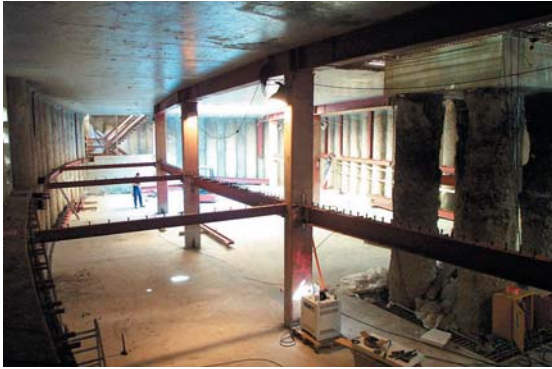
9 Montage der Zwischendecke
